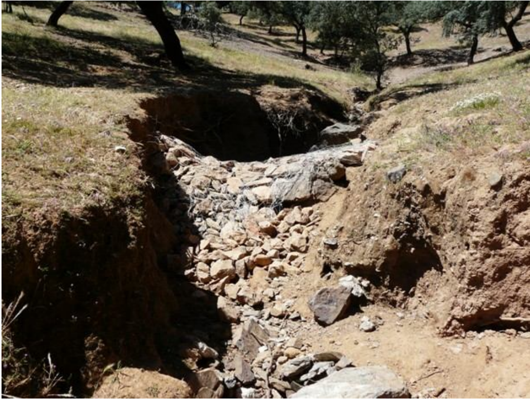
Arreglo de daños erosivos producidos por lluvias
