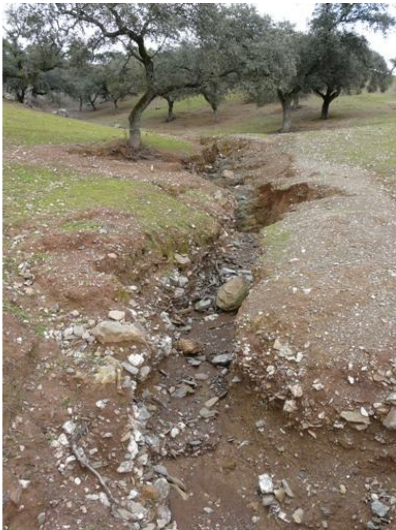
Daños erosivos producidos por lluvias
